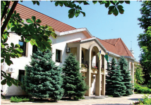
Адміністративна будівля Запорізької митниці
