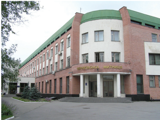
Адміністративна будівля Чернігівської митниці
