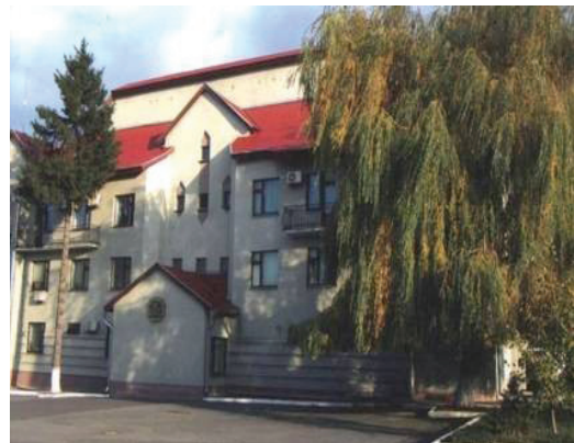
Адміністративна будівля Хмельницької митниці
