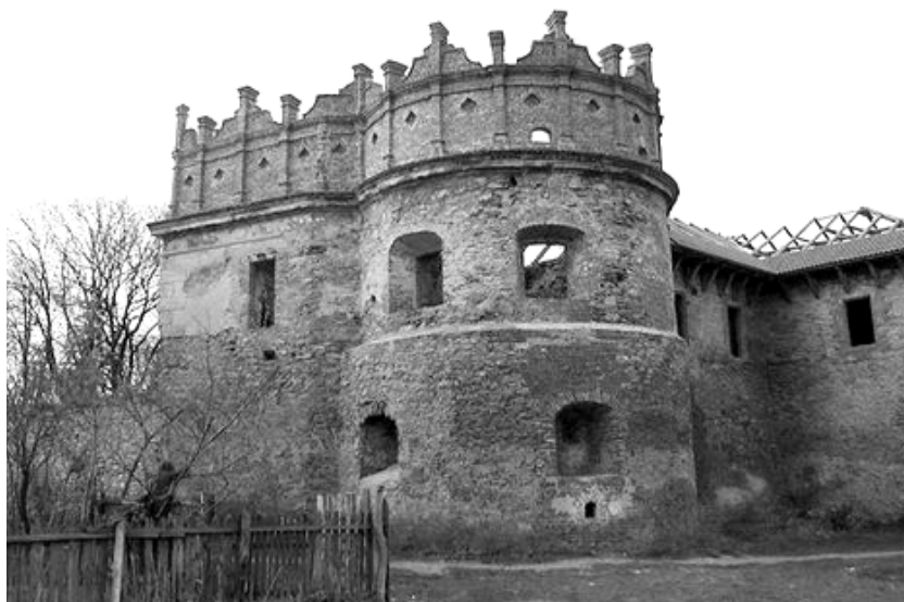
Донжон Староконстянтинівського замку князя К.К.Острозького
