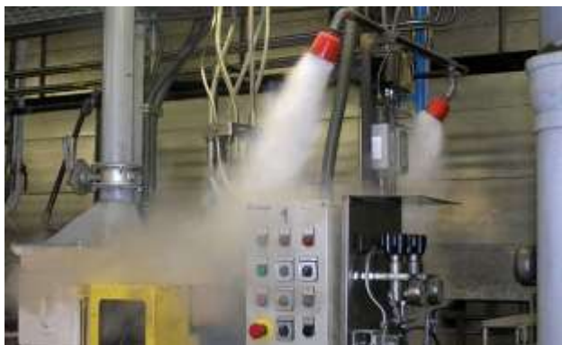
Рис. 13.2.2. Аерозольні системи пожежогасіння
