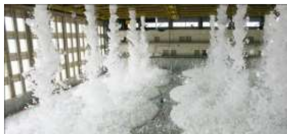
Рис. 13.4. Автоматичні стаціонарні установки пожежогасіння
