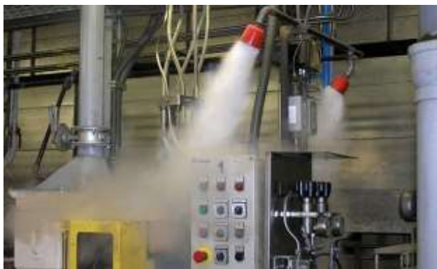
Рис. 13.3. Аерозольні системи пожежогасіння
